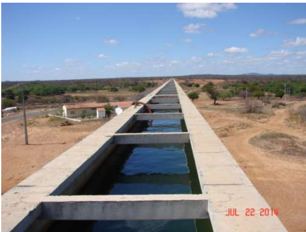
Vista de cima do Aqueduto
