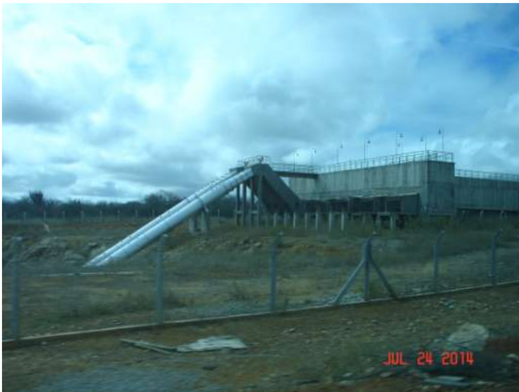
Projeto Salitre – 5ª Estação Elevatória
