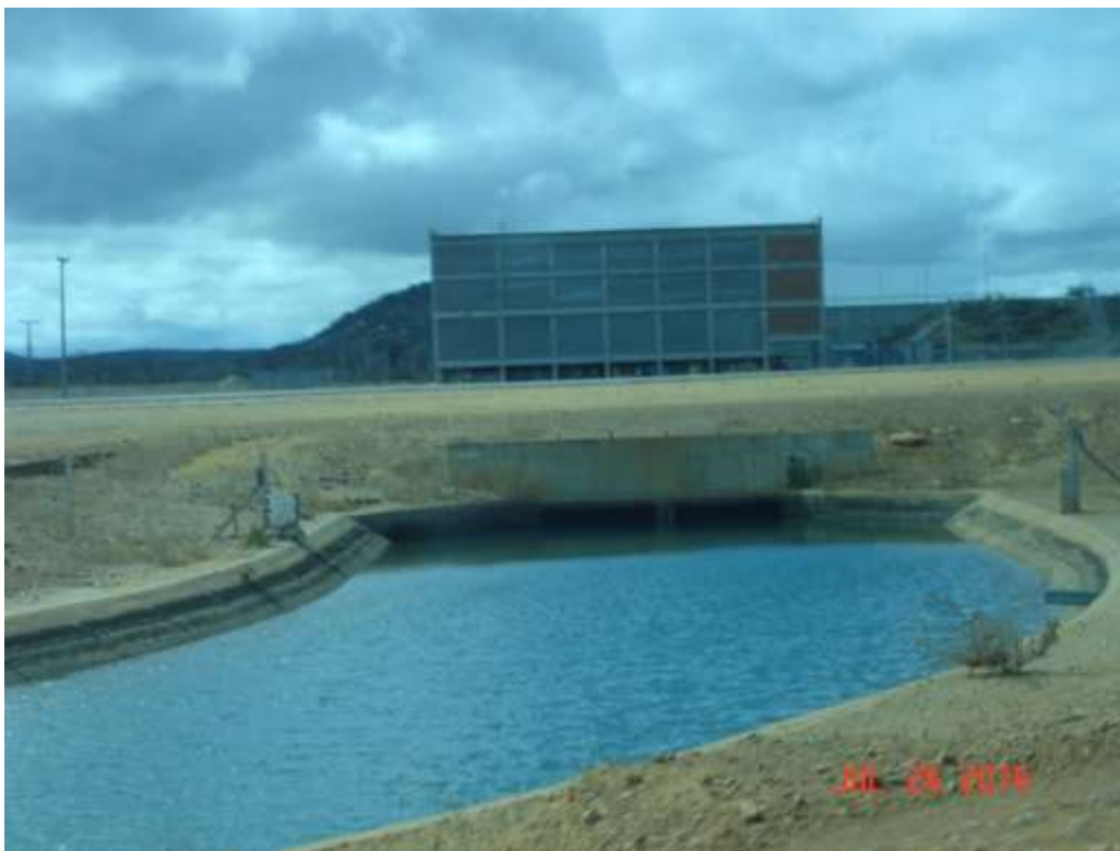
Projeto Salitre – 3ª Estação Elevatória
