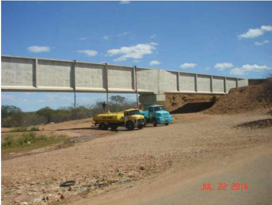
Caminhões Pipa captando água do canal (Projeto Pontal) para distribuição na região
