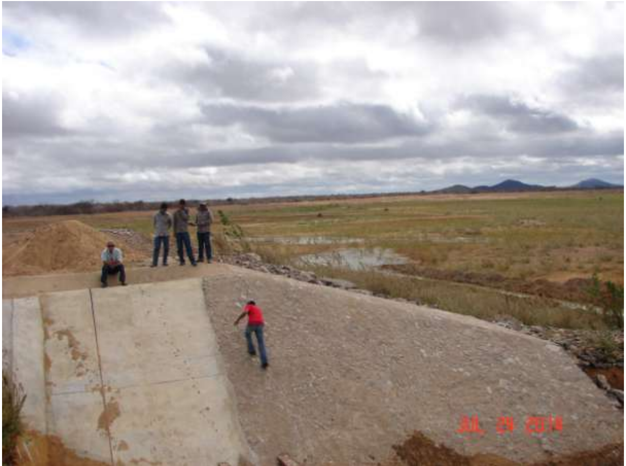
Projeto Salitre – Construção do último reservatório de Distribuição das Etapas implantadas até o momento
