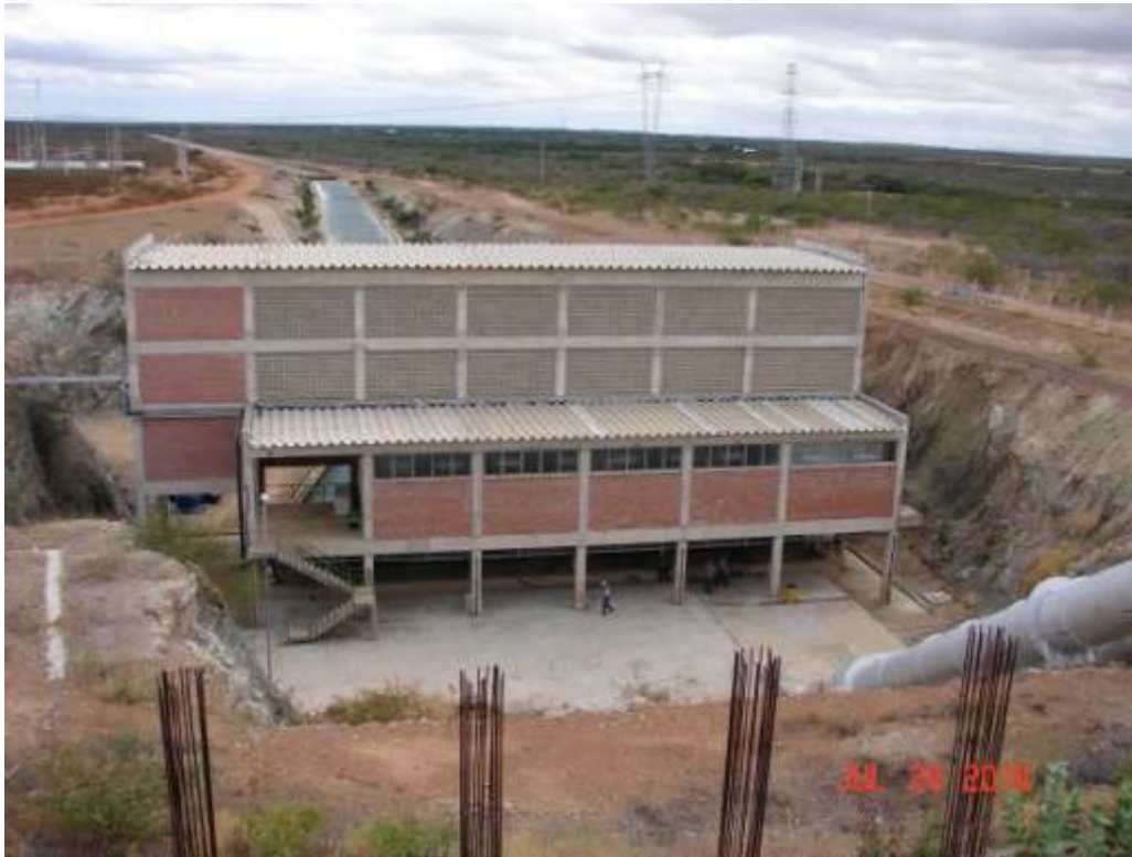
Projeto Salitre – 2ª Estação Elevatória – vista geral
