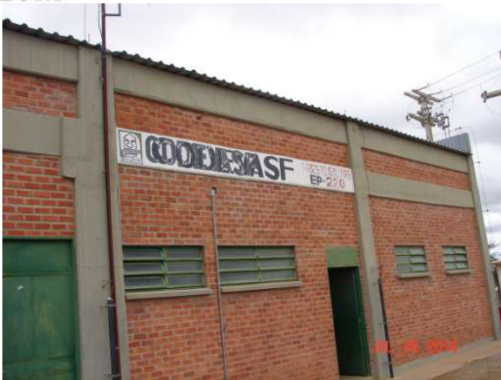
Unidade (Estação) Pressurizadora – Projeto Salitre
