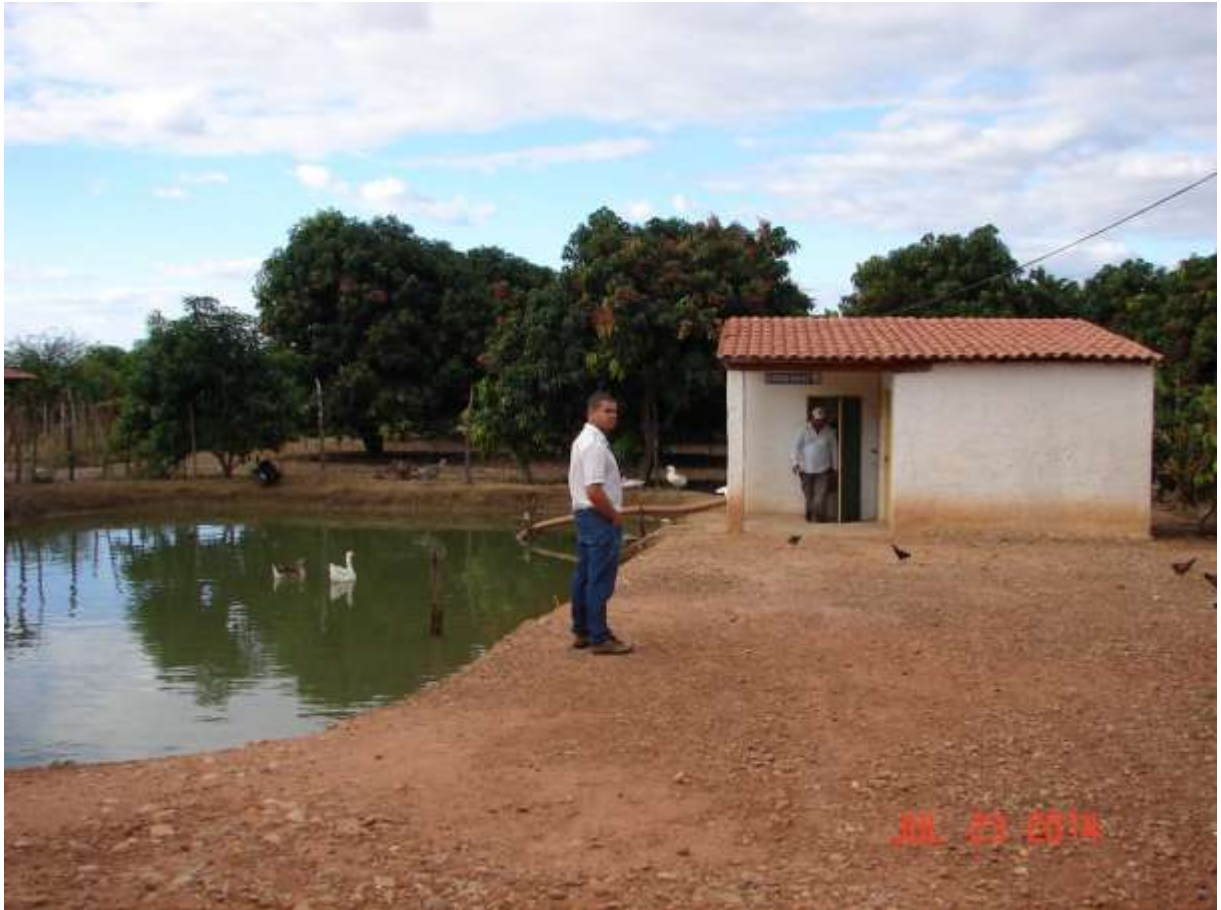
Distrito Mandacarú – Depósito de Água (sem revestimento) e sistema de captação/pressurização/controle – cultura de manga
