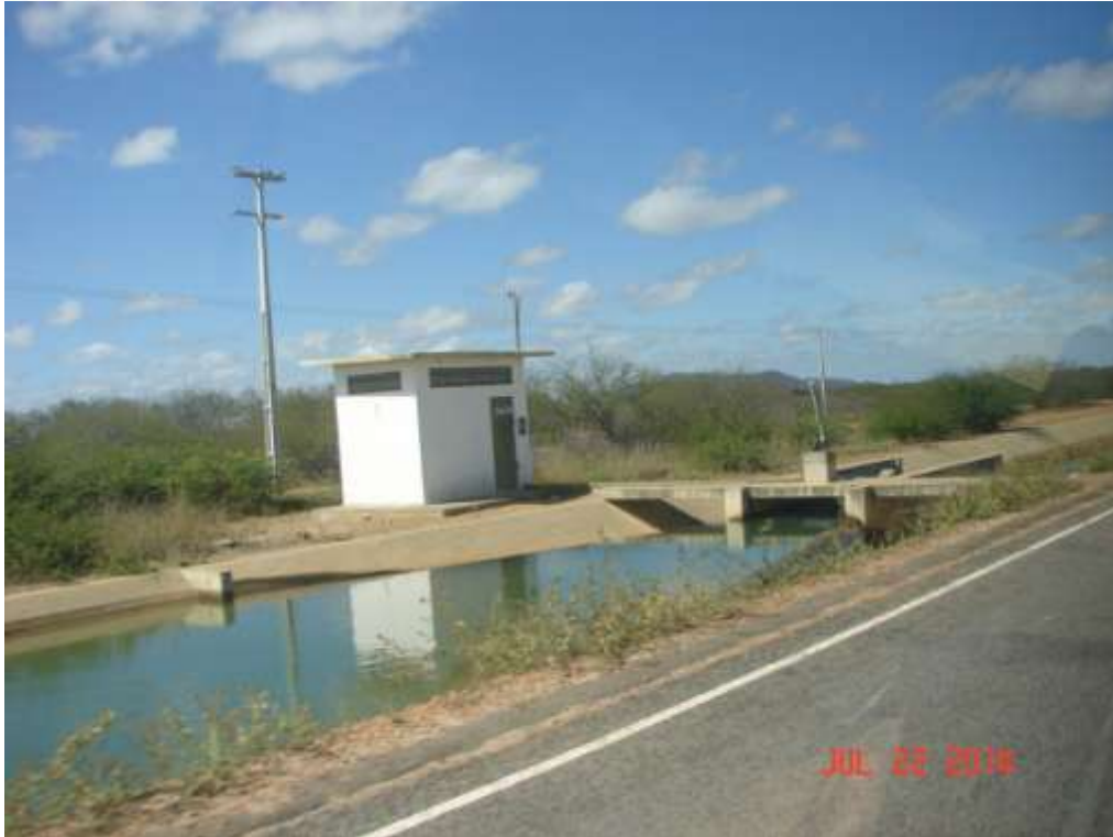
Estação de bombeamento/pressurização e sistema de controle de nível do canal
