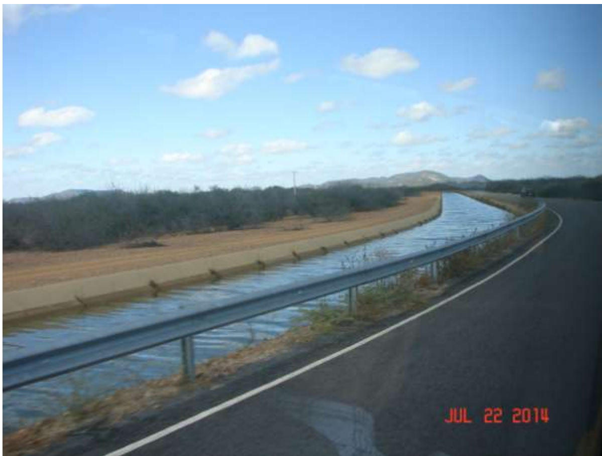
Canal em operação, estrada de serviço e rede elétrica
