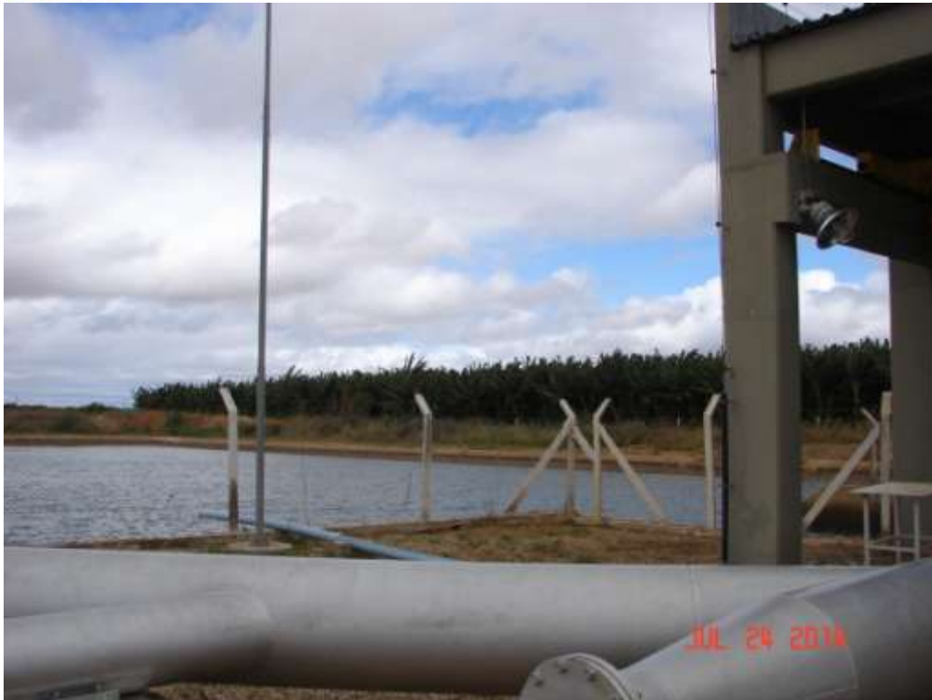
Reservatório Pulmão da Unidade de Pressurização – Projeto Salitre: ao fundo lote usuário do sistema
