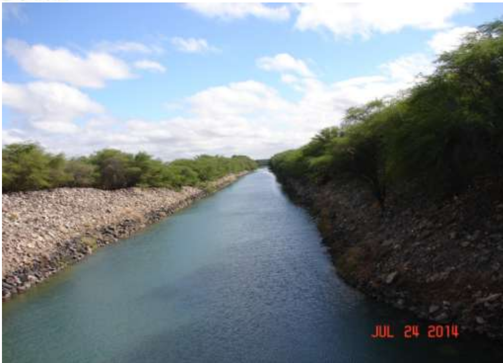
Projeto Salitre – Canal de Aproximação a partir do rio São Francisco para a Estação de Bombeamento Principal
