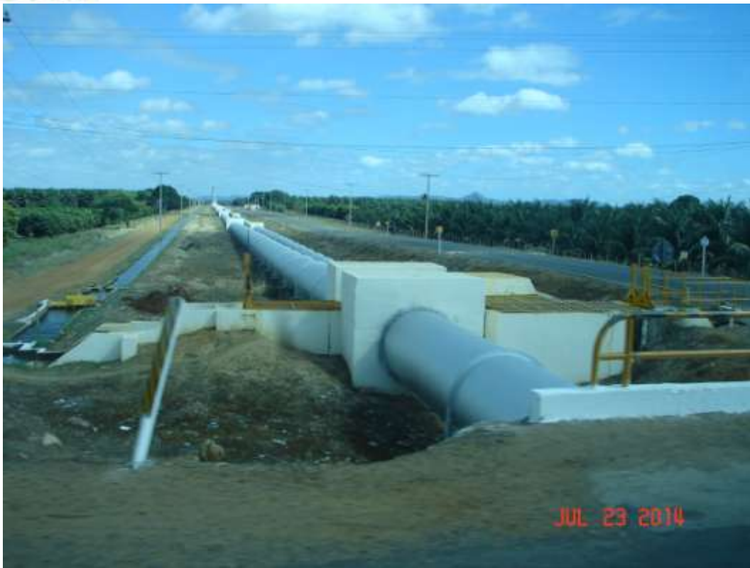
Projeto Maniçoba – Adutora Principal: extensão 2.000 metros
