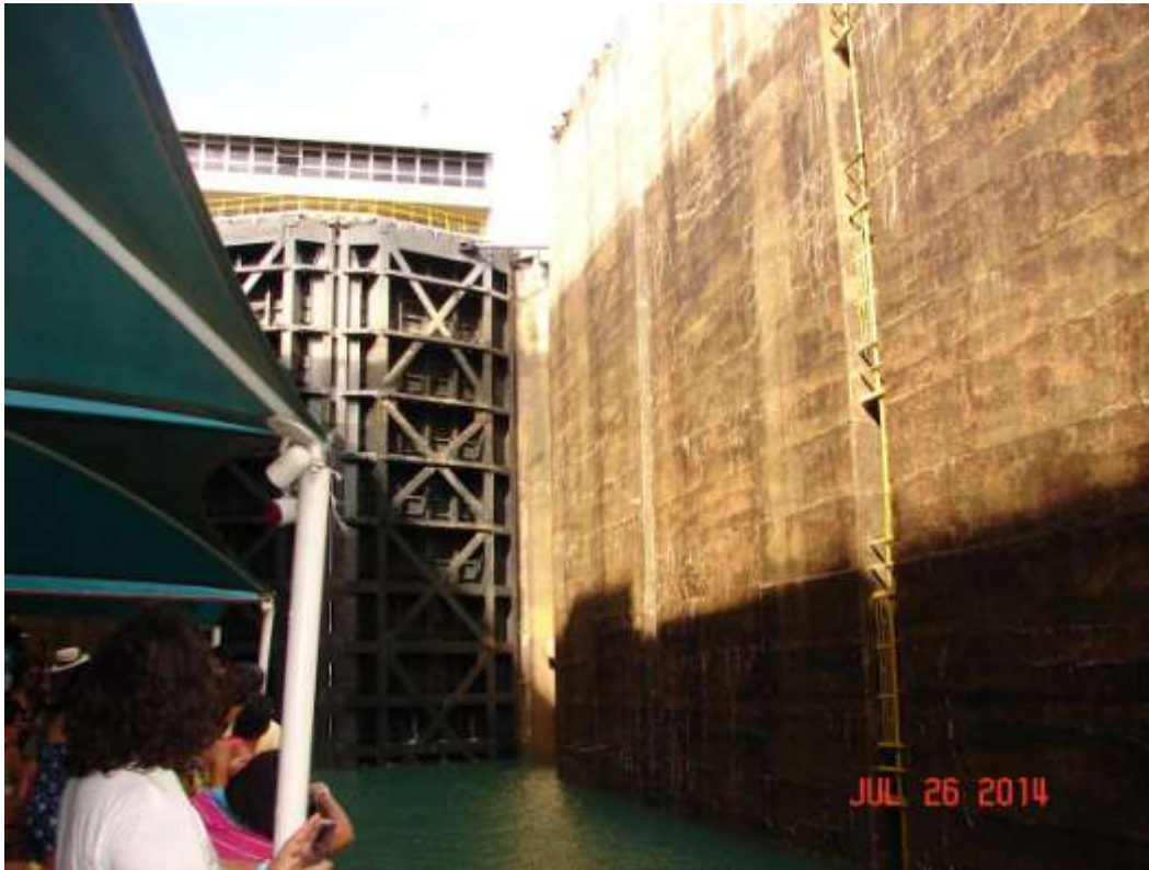
Nivelamento com o rio a jusante da barragem
