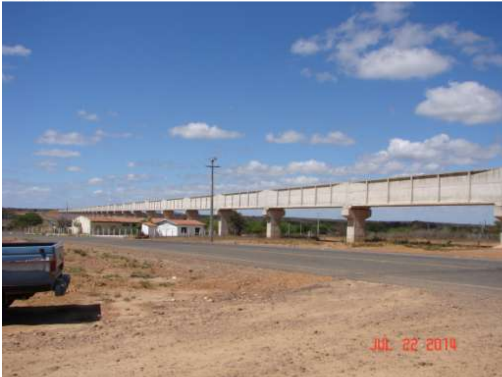
Projeto Pontal – Canal Principal: Aqueduto para transposição de arroio (1Km de extensão)
