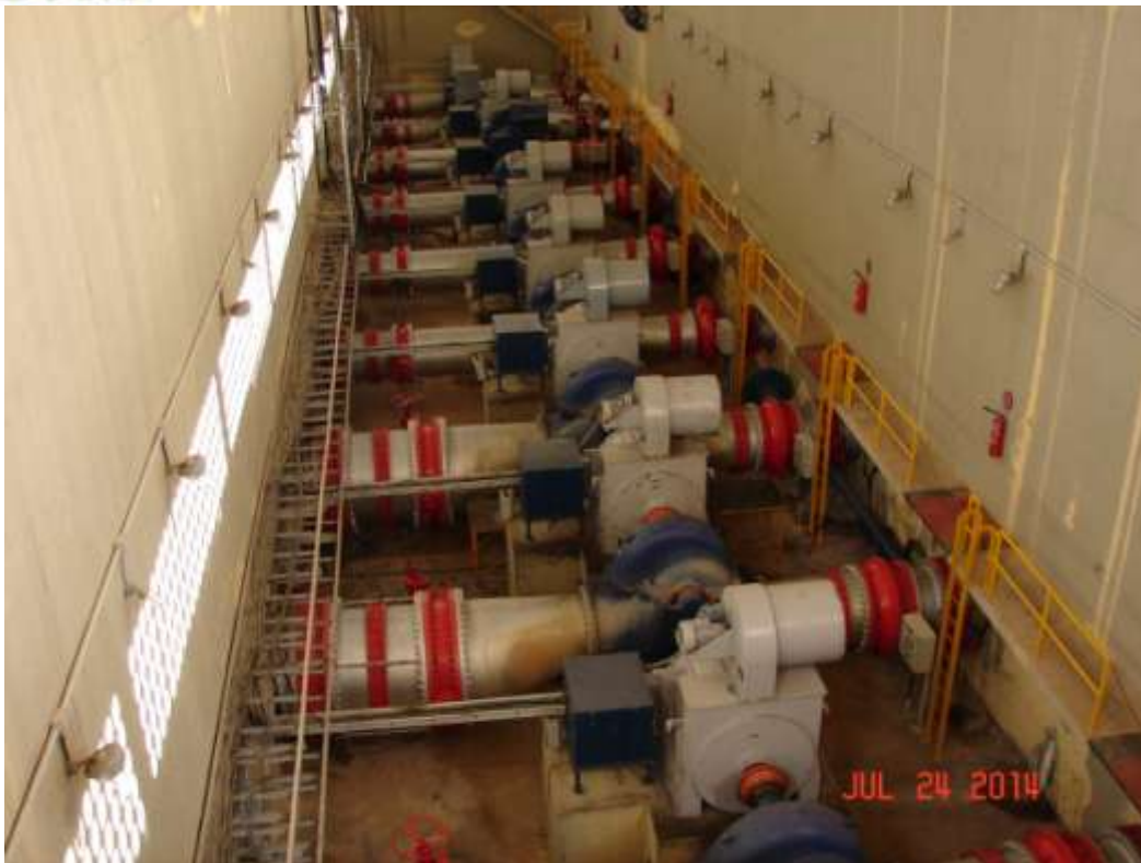
Projeto Nilo Coelho – Estação de bombeamento na barragem de Sobradinho
