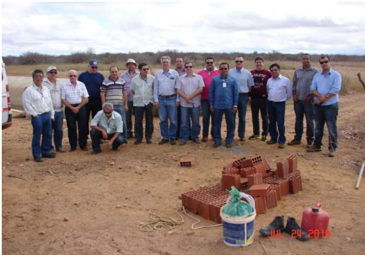
Grupo junto ao Reservatório de Distribuição da 5ª Etapa do Projeto Salitre, em construção
