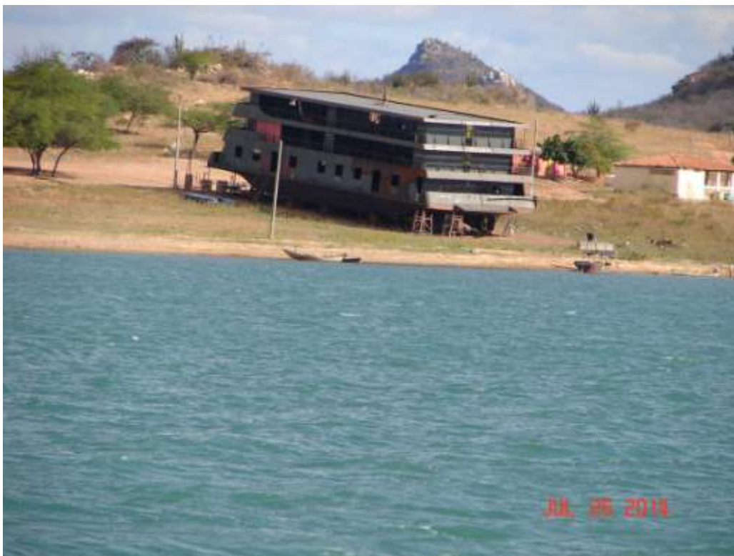
Agência flutuante da Caixa em fase final de construção: percorrerá o rio São Francisco
