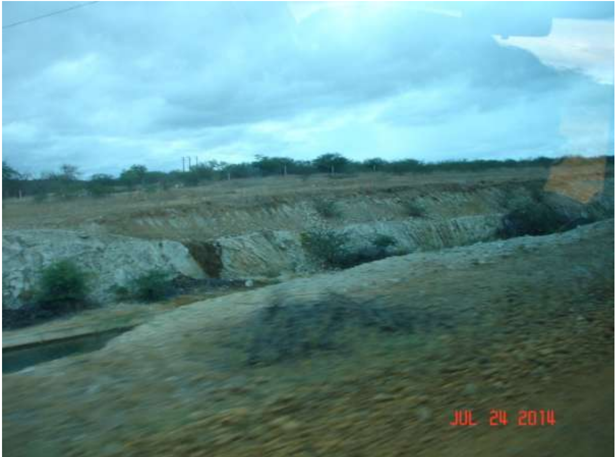
Projeto Salitre – corte para passagem do canal principal (aprox. 10 metros)
