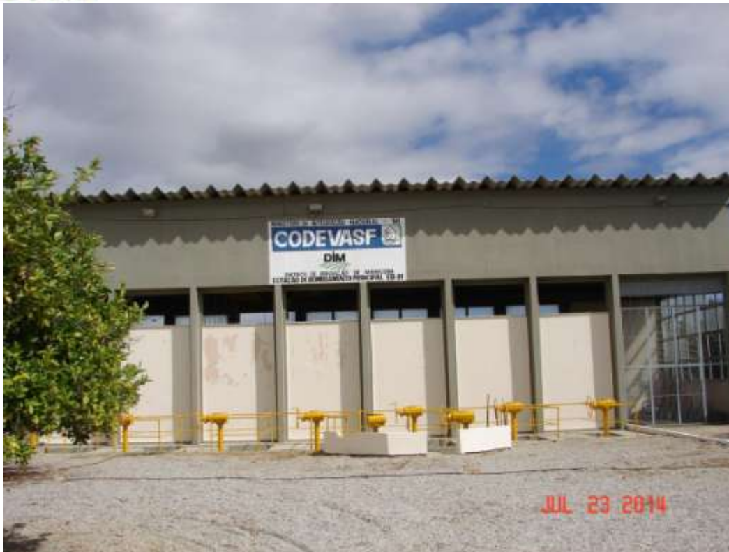
Projeto Maniçoba – Estação de Bombeamento no rio São Francisco
